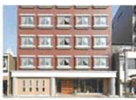
★鉄筋コンクリート6階建て
